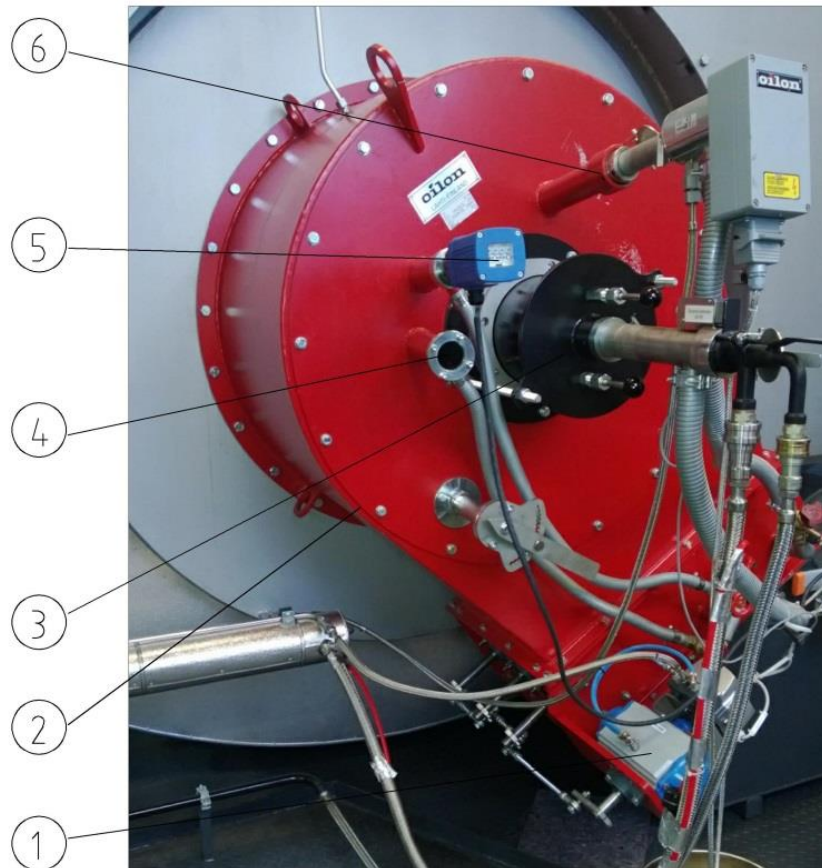
Kuva 6: Oilonin paineilmahajotteinen bioöljypoltin
